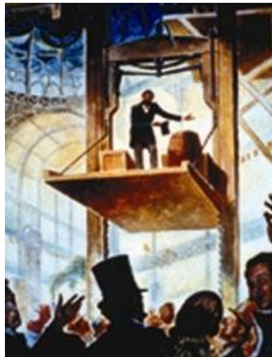
Figura 2.1: Elisha Otis demonstrando travas de segurança ao cortar as cordas (OTIS, 2016).
